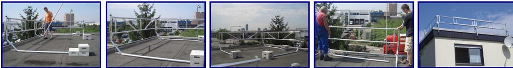
Die Eckpfosten der Geländer sind mit 4 Keilkästchen versehen, um im Eckbereich zügige weiterbauen zu können ohne lästiges Anschrauben von Kupplungen.
